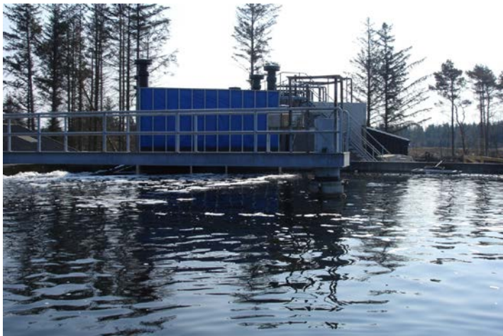
Рис. 35. Биологический фильтр в виде пристройки к модернизированному бассейну форелевой УЗВ (Институт водных ресурсов Датского технического университета, Хиртсшальс, Дания)
