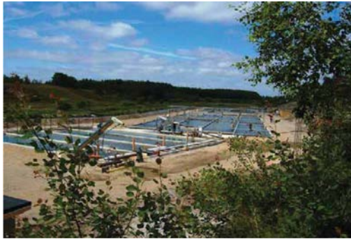
Рис. 3.5. Образцовое рыбное хозяйство Ejstrupholm (тип 3). Производственные подразделения включают две секции, каждая из которых состоит из двух бетонных каналов. На переднем плане видны три пруда для содержания рыбы. На заднем плане слева располагаются биологические пруды, которые состоят из бывших земляных прудов, заросших растениями
