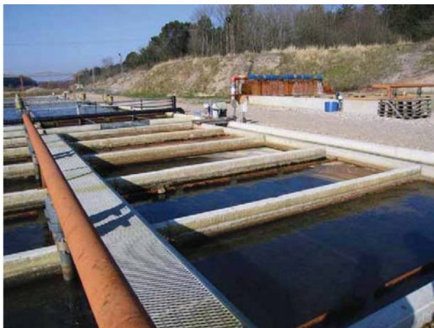
Рис. 3.10. Биофильтры разделены на секции из биоблоков в образцовом форелевом хозяйстве Ejstrupholm (тип 3). Справа от биофильтров находится устройство для аэрации отведенных грунтовых вод и осадков до попадания воды в производственные узлы
