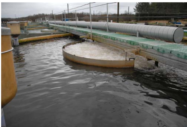
Рис. 5.36. Диффузор низкого давления в центре круглого бассейна
