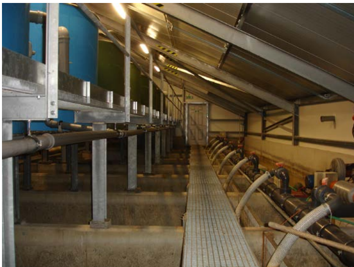
Рис. 36. Комбинированная (двухэтажная) УЗВ из Чехии: первый уровень – каналные бетонные бассейны для выращивания товарной рыбы, второй уровень – круглые бассейны для выращивания мальков
