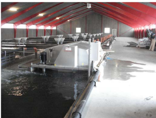
Рис. 10. Барабанный механический микрофильтр Нудротех с ячейей сетки 40 мкм
