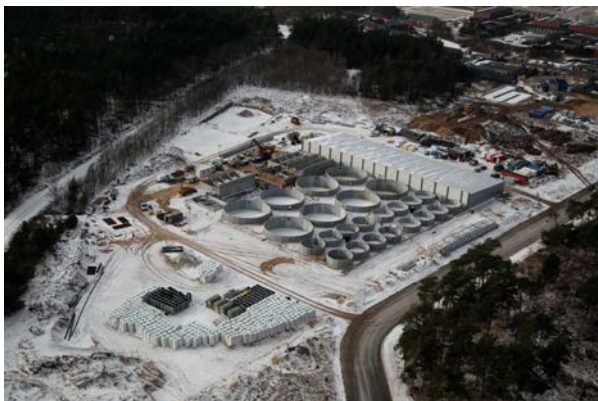
Рис. 29. Строительство УЗВ с бетонными бассейнами круглой формы. Проектная мощность фермы – 4000 т в год. Максимальная плотность посадки в один большой бассейн – до 500 т на бассейн (Danish salmon, Хиртсшальс, Дания)
