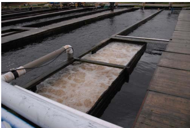
Рис. 5.38. Низконапорный диффузор (во включенном режиме)
