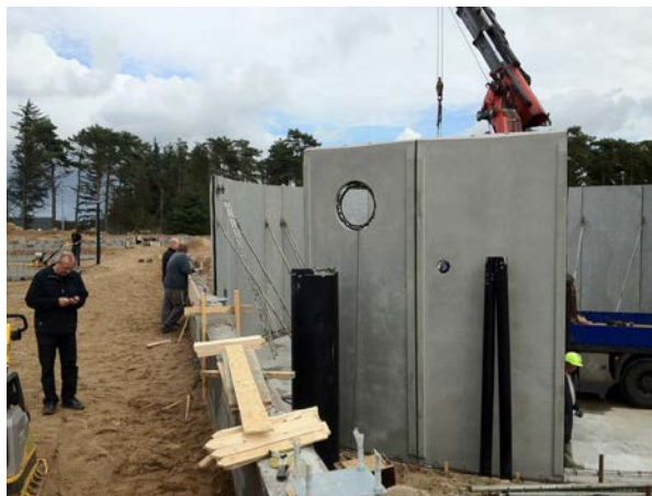
Рис. 30. Монтаж бетонного бассейна круглой формы (Danish salmon, Хиртсшальс, Дания)
