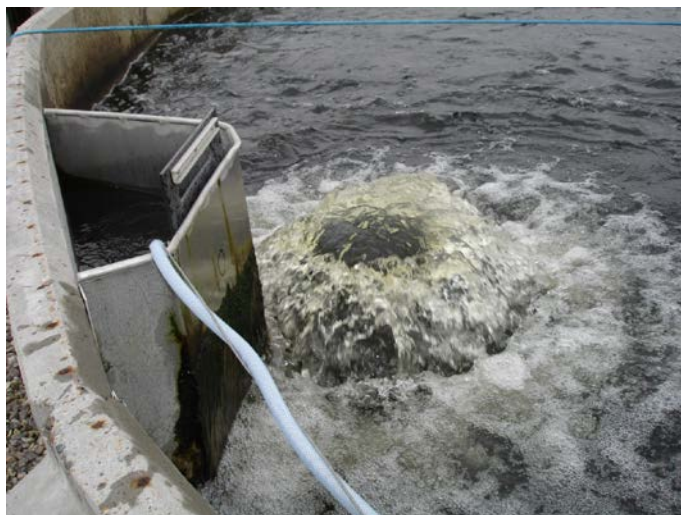
Рис. 9. Выход воды из биофильтра в бассейн с рыбой
