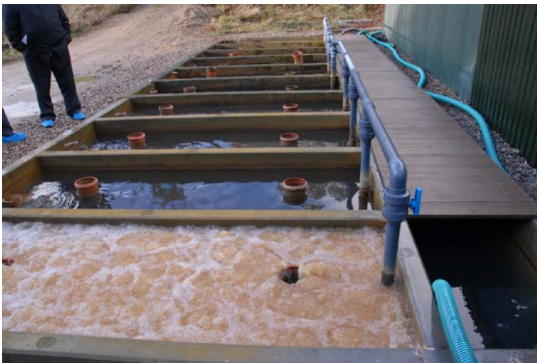
Рис. 5.45. Промыка фильтра сжатым воздухом
