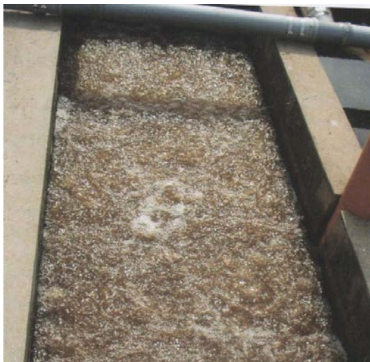
Рис. 5.24. Промывка фильтра
