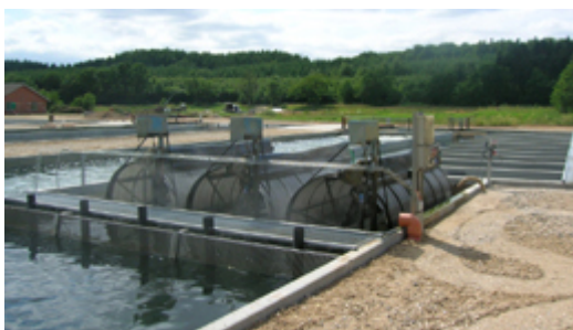
Рис. 5.15. Механический барабанный фильтр (микрофильтр)
