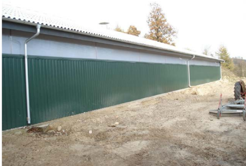
Рис. 2. Основное производственное здание площадью 1300 м 2
