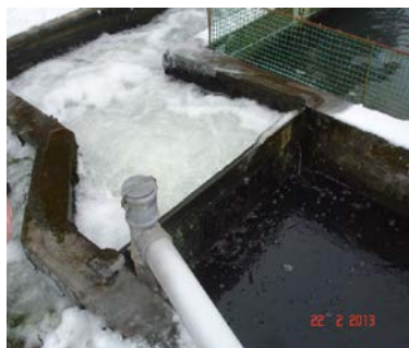
Рис. 5.55. Эрлифт в процессе работы
