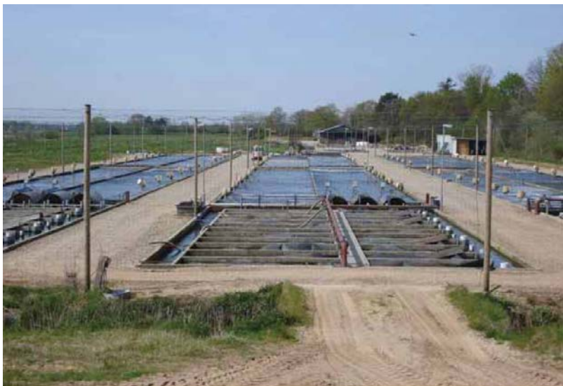
Рис. 3.7. Образцовое форелевое хозяйство Kongeåens (тип 3). Производственные подразделения включают в себя три секции, каждая из которых состоит из двух бетонных дорожек с микроситами (размер ячейки – 74 мкм) перед секцией биофилтра (на переднем плане). Слева расположены биологические пруды, состоящие из бывших земляных прудов и впускных и выпускных каналов (Svendsen et al., 2008)
