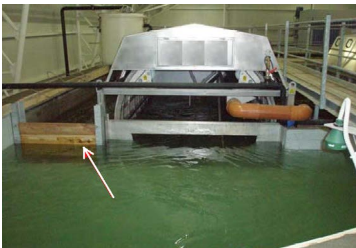
Рис. 22. Механический фильтр. Стрелкой указан шандорный перелив (в случае аварии)
