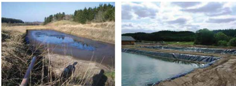
Рис. 3.9. Из шламовых конусов шлам поступает в бассейны (емкости) для твердых частиц. Слева – образцовое ферелевое хозяйство Ejstrupholm; справа – образцовое ферелевое хозяйство Løjstrup
