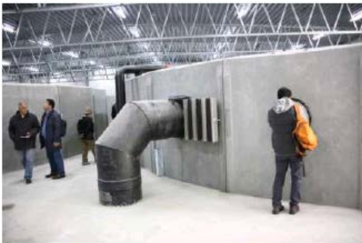
Рис. 31. Вид снаружи на производственный бассейн (Danish salmon, Хиртсшальс, Дания)
