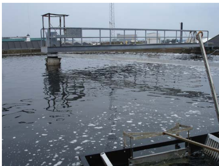
Рис. 34. Модернизированный бассейн форелевой УЗВ (Институт водных ресурсов Датского технического университета, Хиртсшалье, Дания)
